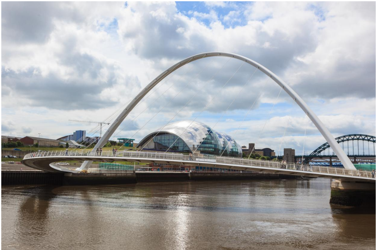
Millennium Brücke und The Sage Gateshead
